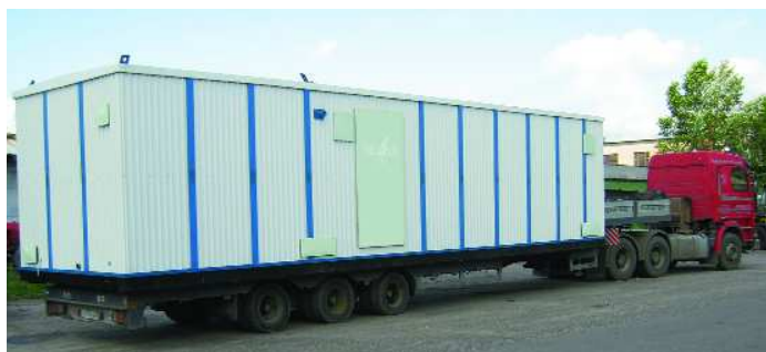
Транспортировка контейнера NeuHaus с ДГУ FG Wilson мощностью 1 МВт к месту установки
