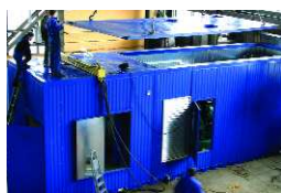
Производство контейнера NeuHaus для ДГУ 2,25 МВт
