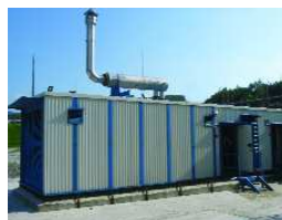
Контейнер NeuHaus в процессе монтажа
