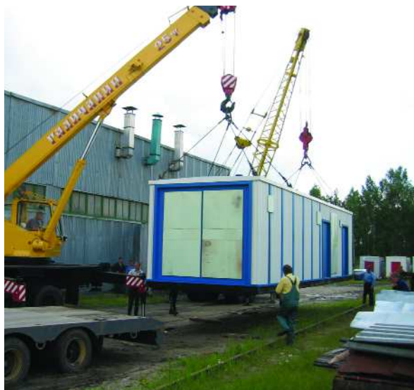
Погрузка на платформу изготовленного НойХаус Групп контейнера с размещенной в нем дизель-генераторной установкой
