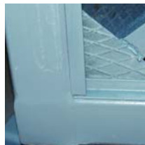
Грунтовка каркаса
