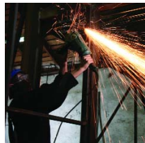
Обработка сварного каркаса
