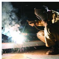
Сварка несущих конструкций
