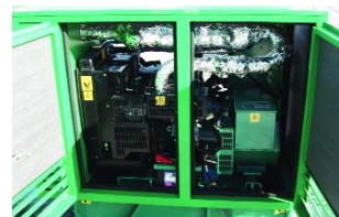
Шумозащитный кожух производства НойХаус Групп. Изготовлено производственным отделом компании для ДГУ Cummins C11 D5.
