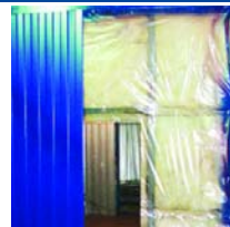
Сборка модуль-контейнера, пароконструкция и термоизоляция
