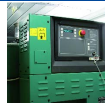
Установка ДГУ в контейнер. Жесткость основания обеспечена конструкцией.
