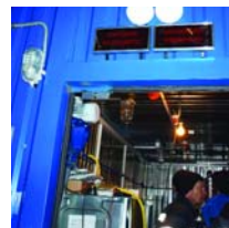
Установка вспомогательных систем
